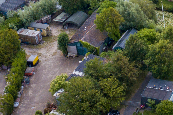
te slopen bijgebouwen
